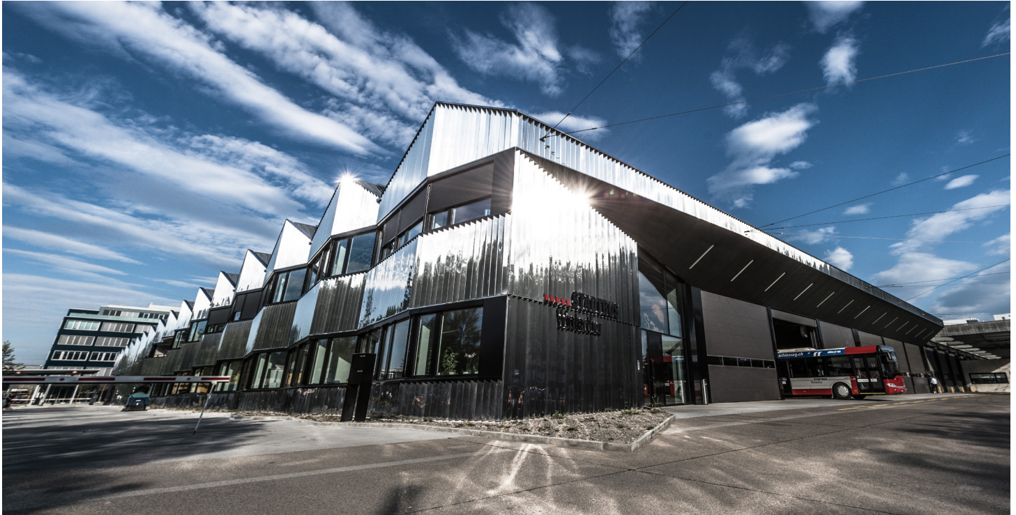
Der Neubau des Busdepots Grüzefeld in Winterthur
